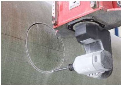
Drilling of nozzles Ouverture des piquages
